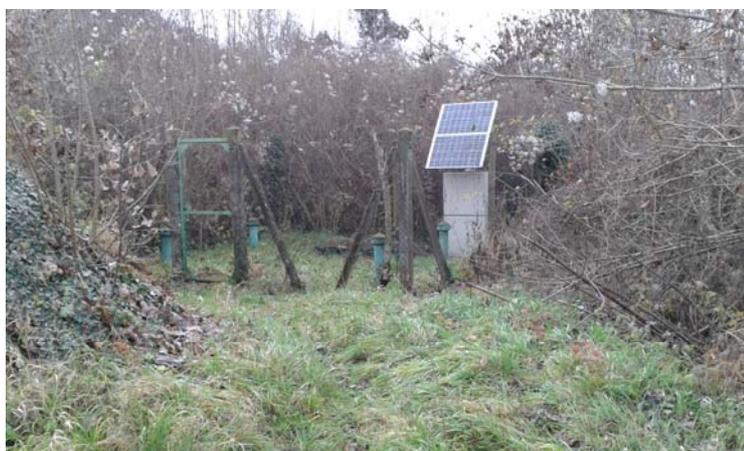
Depuis le 1<sup>er</sup> Janvier 2014, la commune de Dornot a rejoint le SIEGVO. Son alimentation en eau potable est effectuée à partir d'un puits captant les alluvions de la Moselle. La station de pompage est équipée de 2 pompes immergée (fonctionnement alternatif) de 8 m<sup>3</sup>/h. Avant d'être refoulée vers le réservoir, l'eau subit un traitement de désinfection à l'eau de Javel. Le réservoir, d'une capacité de 120 m<sup>3</sup>, alimente gravitairement la commune.
