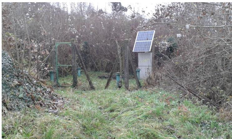
Depuis le 1<sup>er</sup> Janvier 2014, la commune de Dornot a rejoint le SIEGVO. Son alimentation en eau potable est effectuée à partir d'un puits captant les alluvions de la Moselle. La station de pompage est équipée de 2 pompes immergées (fonctionnement alternatif) de 8 m<sup>3</sup>/h. Avant d'être refoulée vers le réservoir, l'eau subit un traitement de désinfection à l'eau de Javel. Le réservoir, d'une capacité de 120 m<sup>3</sup>, alimente gravitairement la commune.
