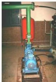
8 Puits sont implantés dans la nappe alluviale de la Moselle sur le ban de la Commune de Uckange (accès par CD 122d Fameck-Uckange). L'eau est recueillie dans une bache de 30 m<sup>3</sup> avant d'être refoulée vers la station de Nouvelle Brouck située à environ 1500 ml. La station de pompage d'Ancienne Brouck est équipée de 2 pompes centrifuges (fonctionnement alternatif) de 30 m<sup>3</sup>/h.
